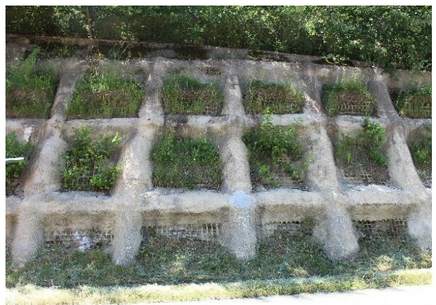
Abb. 3 Sonderkonstruktion einer rippenartigen Spritzbetonkonstruktion zur Sicherung eines Hangeinschnittes
