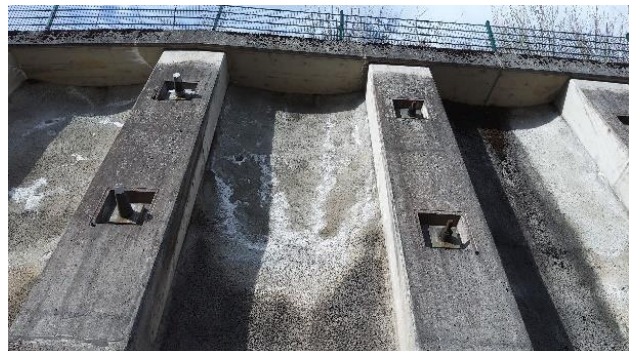
Abb. 2 Anwendungsbeispiel von Spritzbeton bei geotechnischen Bauwerken, kombiniert mit Ankerlisernen
