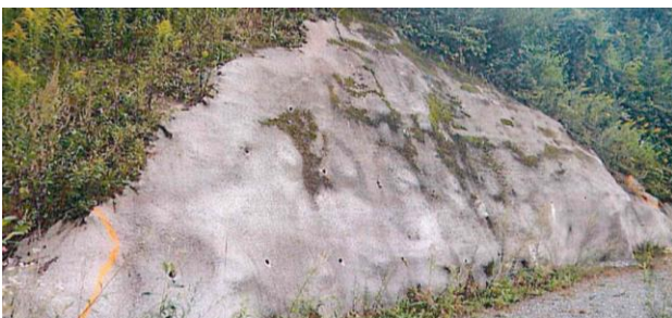
Abb. 1 Anwendungsbeispiel von Spritzbeton bei geotechnischen Bauwerken, alleinstehende Konstruktion
