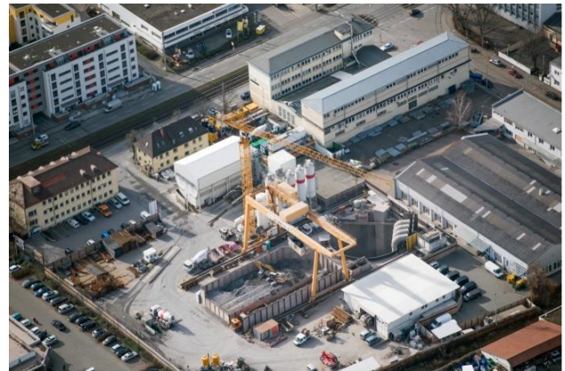
Abb. 8 Luftaufnahme Baustelleneinrichtung Ulmer Straße mit Mischanlage (Bild: Arnim Kilgus)
