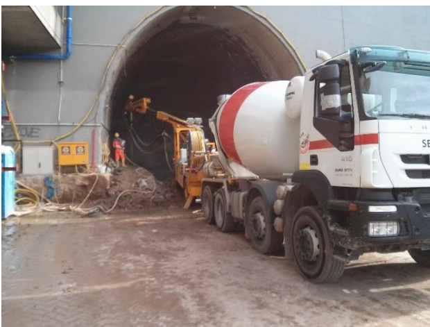
Abb. 12 Tunnelanschlag am Zwischenangriff Ulmer Straße (Bild: Arnim Kilgus)
