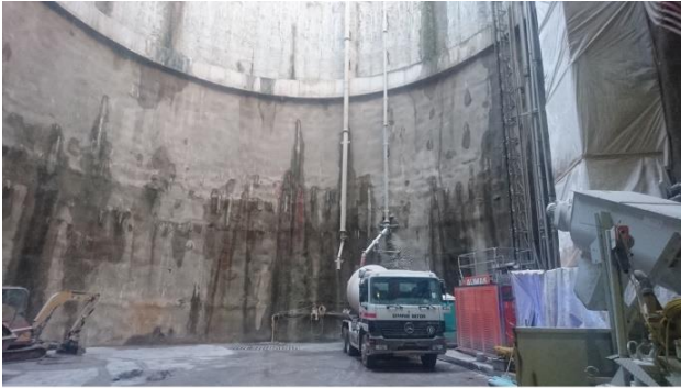
Abb. 9 Betonübergabe am Zugangsschacht Ulmer Straße in den Fahrnischer (Bild: Arnim Kilgus)
