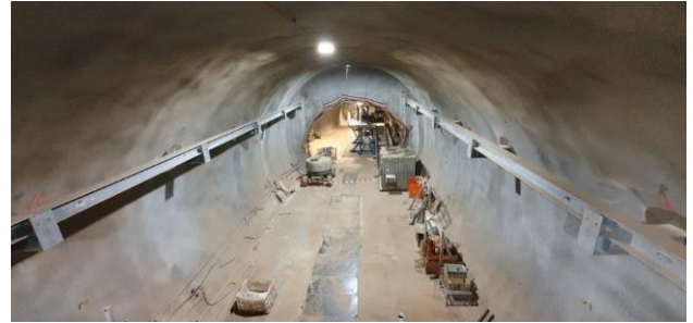
Abb. 9 fertige Innenschale aus Stahlfasernassspritzbeton
