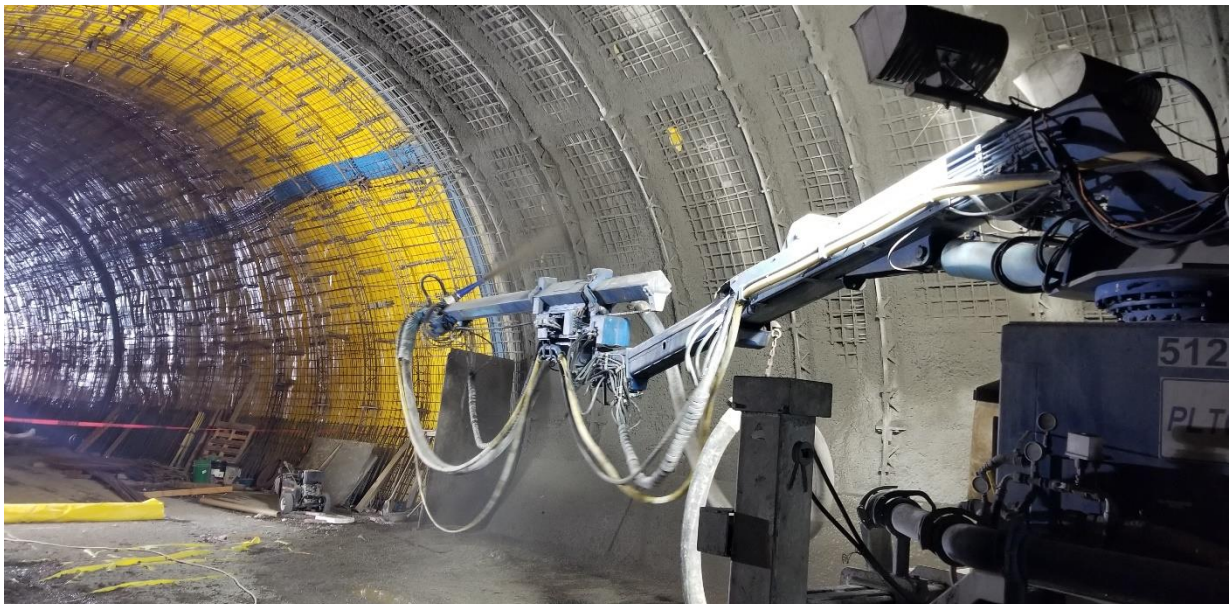
Bild 10: Spritzen der Innenschale auf PVC-KDB
