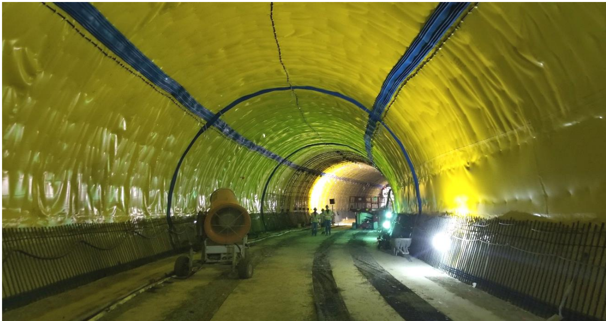
Bild 8: Sohlbeton und PVC-Kunststoffdichtungsbahn im Tunnelgewölbe
