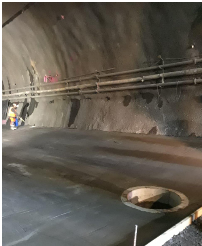
Bild 7: Sauberkeitsschicht Tunnelsohle
