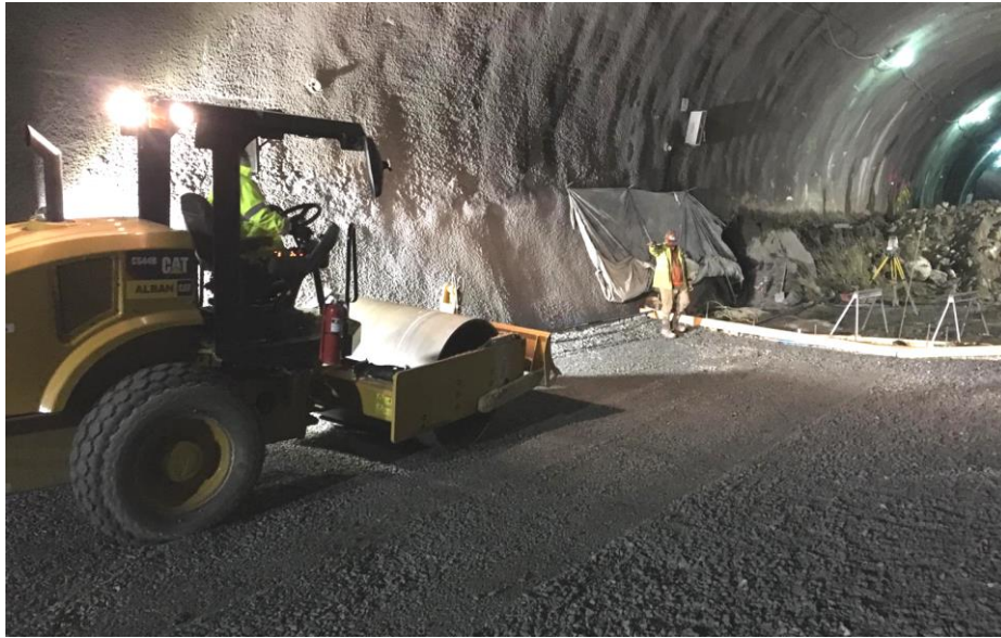
Bild 6: Einbau der Sauberkeitsschicht in der Tunnelsohle
