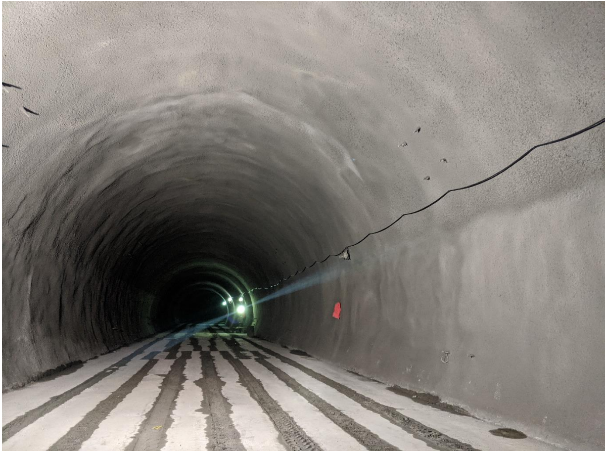
Bild 11: Spritzbetoninnenschale nach Abschluss der Arbeiten
