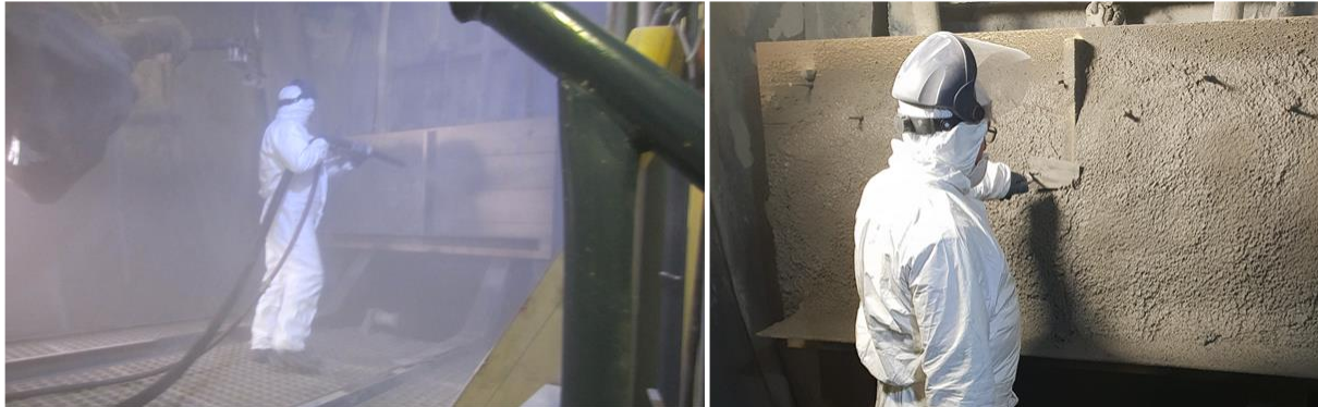
Bild 10: Applikation des Geopolymerspritzbetons im Spritzbetonversuchsstand der Ruhr-Universität Bochum nach [10]
