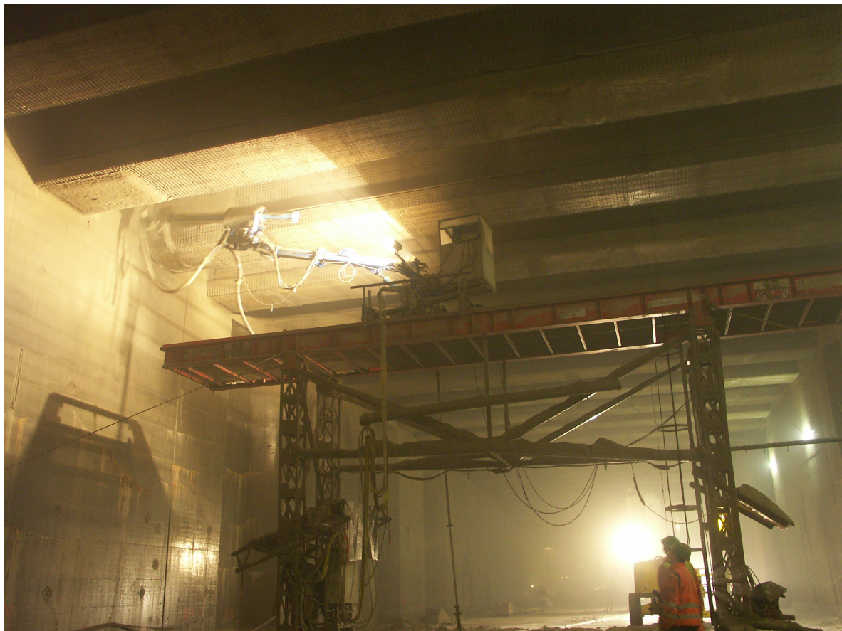
Bild 2: Auftrag Brandschutz-Spritzmörtel im Lainzer Tunnel mit Spritzroboter (Foto Vogl [4])
