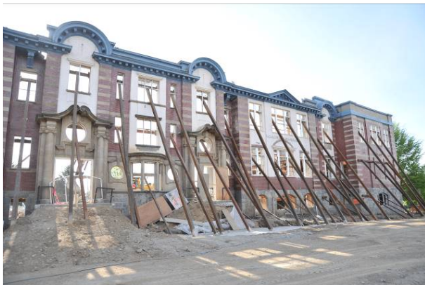
Bild 3: Ridgeway School, North Vancouver, nach dem Entkernen
