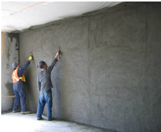
Bild 17: Glätten der Spritzbetonoberfläche Quelle: LRutt
