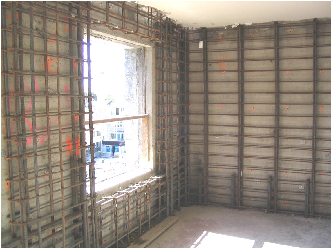
Bild 10: Installierte Bewehrung. Quelle: LRutt
