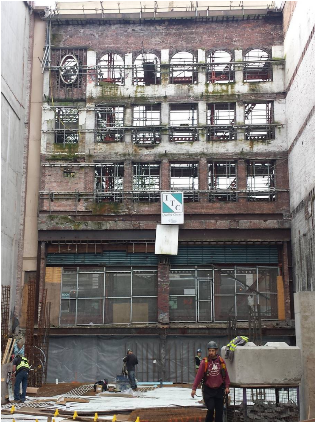
Bild 7: Beispiel einer Fassade nach dem Entkernen. Innenansicht. Stützskelett größtenteils verdeckt auf der abgewandten Seite, aber Anschlüsse sichtbar als horizontale Gerüstelemente. Quelle: ITC
