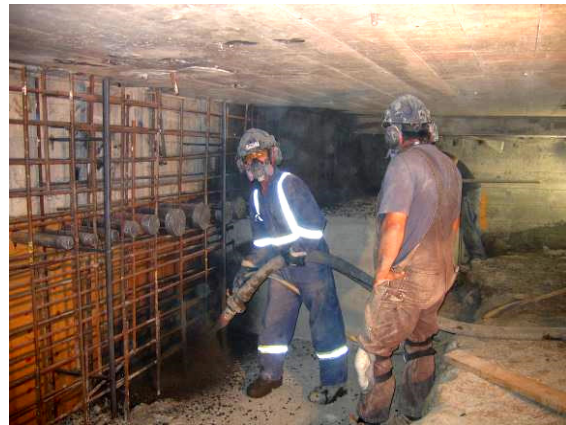
Bild 14: Fundamentvergrößerung mit Spritzbeton
