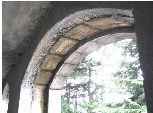
Bild 18: Verbund zwischen neuer Spritzbetonschale und Altbestand aus Ziegel und Granitmauerwerk
