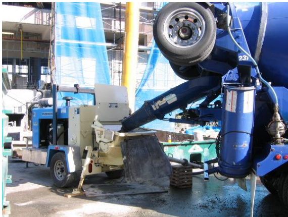
Bild 13: Typische Spritzbetonpumpe, Beschickung vom Mischfahrzeug
