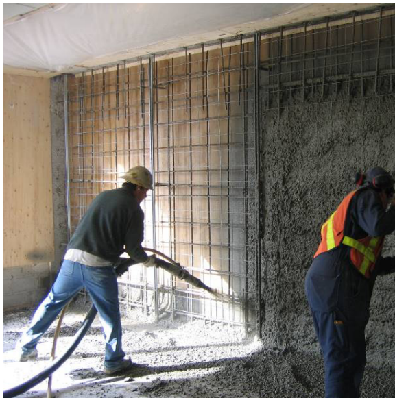
Bild 15: Spritzen einer neuen Querwand Quelle: LRutt
