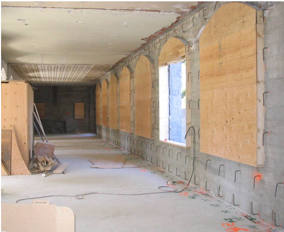
Bild 9: Anker installiert in historische Beton- und Natursteinwand. Quelle: LRutt
