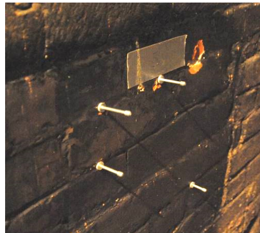
Bild 6: Abschätzen der Mörtelfestigkeit mit dem DX-450 Bolzensetzgerät
