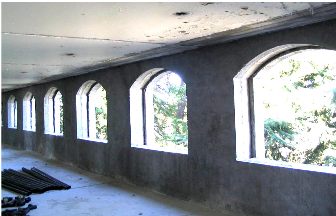
Bild 11: Ortbeton- und Natursteinwand nach dem Spritzbetoneinbau auf der Innenseite. Quelle: LRutt
