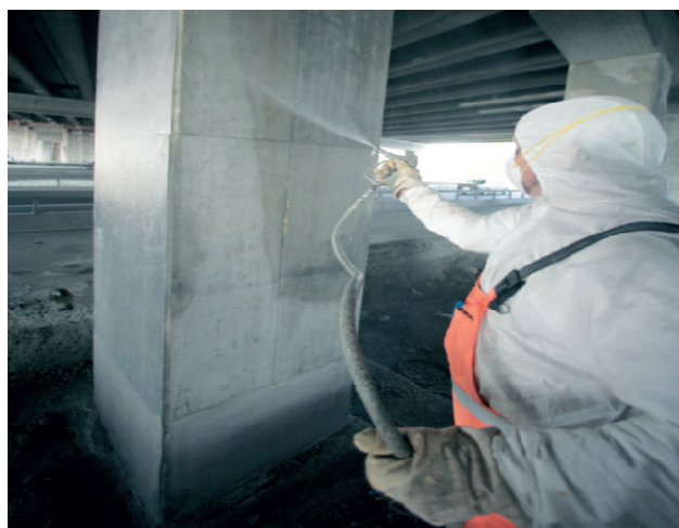
Bild 3: Aufspritzen einer Hydrophobierung im Airlessverfahren
