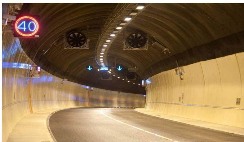
Bild 9: Fertiggestellter Hindhead Tunnel mit Anstrich im Ulmbereich [Bild: BASF]
