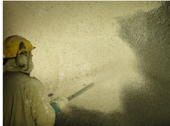
Bild 12 und 13: Applikation der Spritzabdichtung im Gevingas Tunnel (Bild: BASF)
