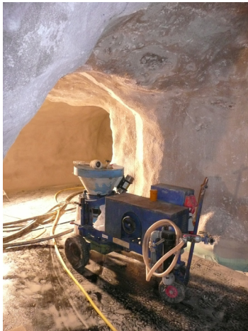
Bild 3: Rotor-spritzmaschine vor dem Spritzen (Bild: BASF)
