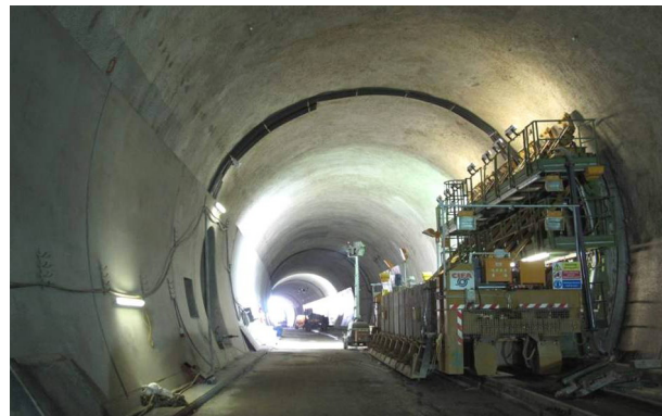
Bild 8: Innenschale, links Ulme betoniert, rechts Schalwagen (Bild: BASF)
