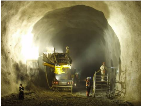
Bild 12 und 13: Applikation der Spritzabdichtung im Gevingas Tunnel (Bild: BASF)
