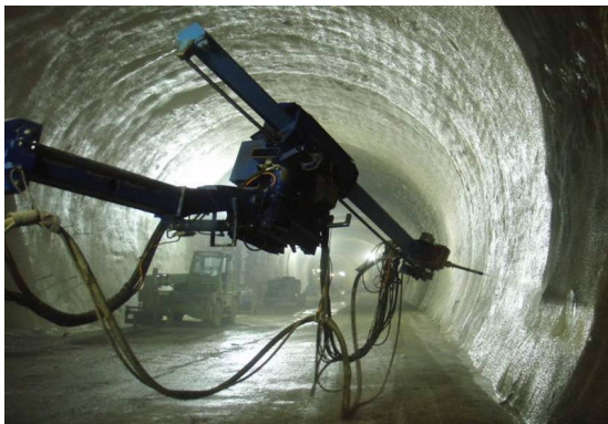
Bild 7: Applikation mit Spritzroboter (Bild: BASF)
