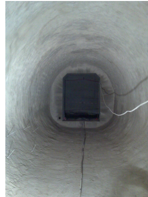
Bild 2: Fertiggestellte Spritzabdichtung im Querschlag (Bild: BASF)
