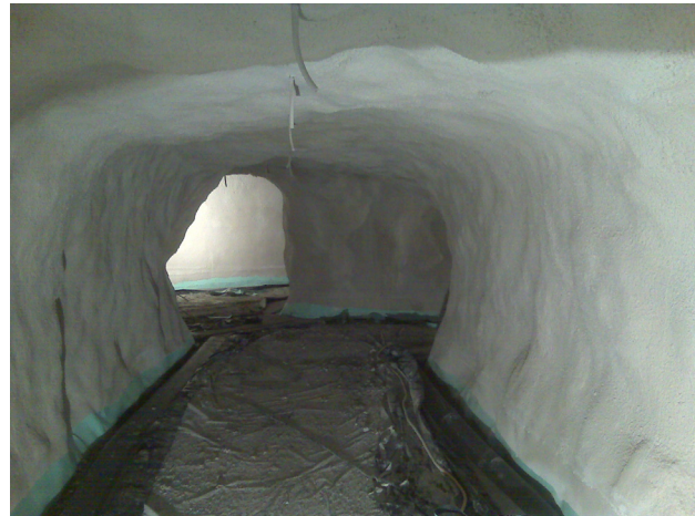
Bild 4: Applizierte Spritzfolie, Anschluss an PVC Folie in Sohle (Bild: BASF)
