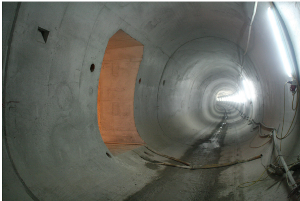
Bild 1: Kreuzungsblock WDI Schale mit Querschlag (Bild: BASF)
