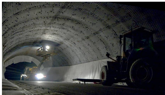
Bild 11: Gewölbe aus PE Schaum Platten mit Bewehrung (Bild: BASF)
