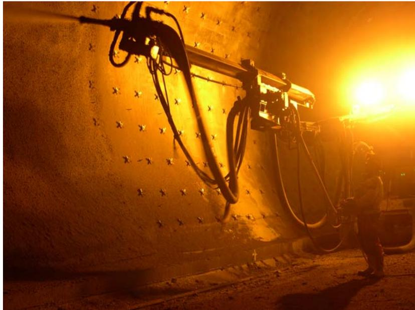
*Bild 8: Spritzbetonauftrag auf bestehende Innenschale mit bauseitig vorbereiteten Verankerungselementen*
