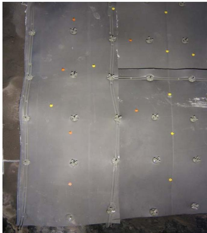
*Bild 6: Detailaufnahme der fertig installierten Matten vor Spritzbetonauftrag; Verankerungselemente, vordere Platte, Stegbänder und Spritzbetonspione wurden installiert*
