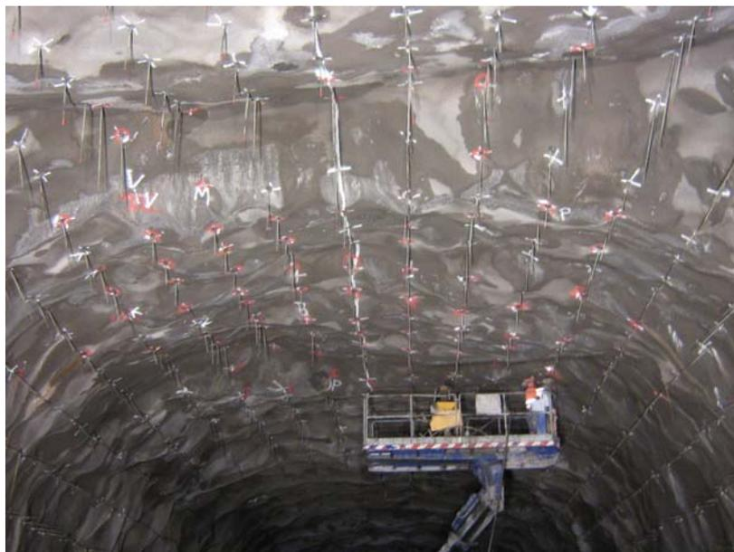
*Bild 4: Exaktes radiales Versetzen der vollvermörtelten Anker, Tunnel Tröingeberg*
