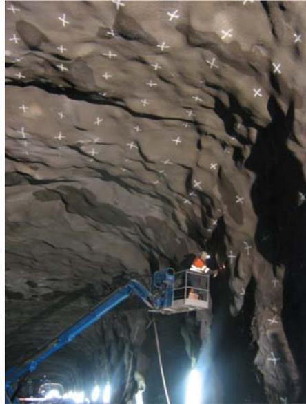
*Bild 3: Anzeichnen der Verankerungspunkte der Dränmatten, Tunnel Tröingeberg*
