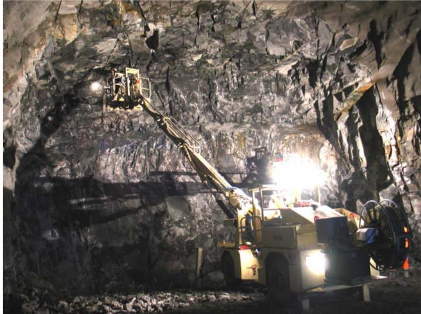
*Bild 2: Absicherungsarbeiten Tunnel Tröingeberg*
