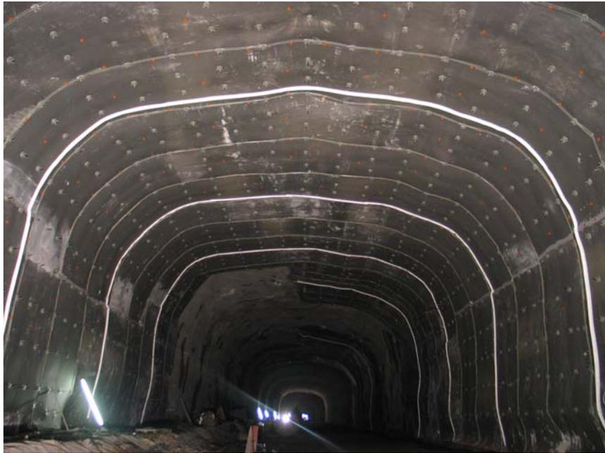
*Bild 5: Fertig installierte Dränmatten mit Sollbruchstellen*
