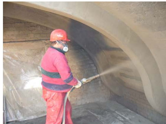
Bild 8: Aufspritzen der Feinbetonschicht
