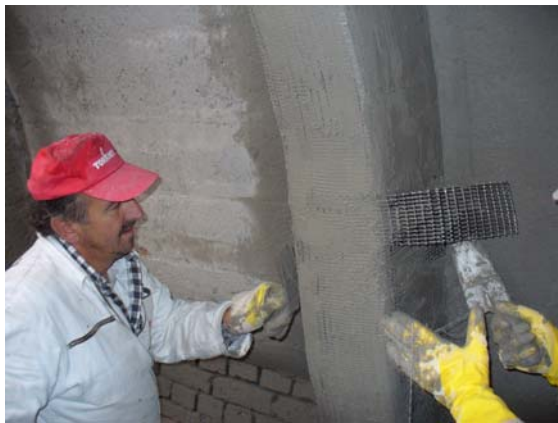
Bild 7: Einlegen des Textils
