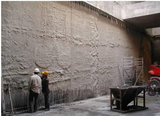
*Bild 18: Begutachten der aufgetragenen Spritzabdichtung (Bild: BASF)*
