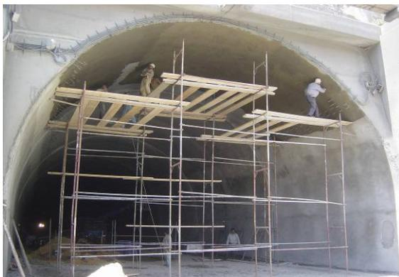
*Bild 9: Glätten der Oberflächen (Bild: BASF)*
