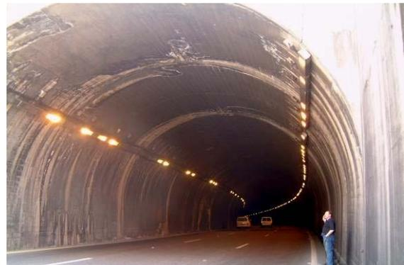
*Bild 6: Chekka Highway Tunnel, vor Sanierung (Bild: BASF)*
