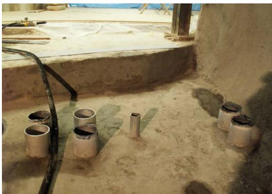
Bild 16: Durchdringungsdetail vor Abdichtung (Bild: BASF)
