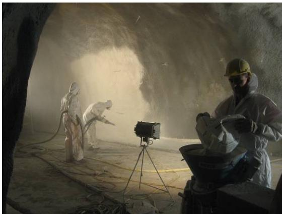
*Bild 11: Spritzauftrag der Abdichtungsmembran bei Hand (Bild: Hinteregger)*
