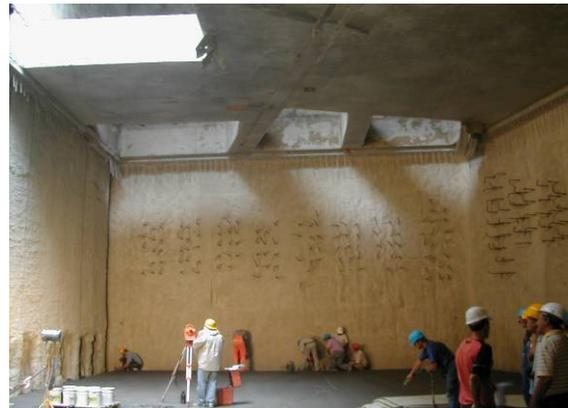
*Bild 19: Nach Auftrag der Spritzabdichtung (Bild: BASF)*
