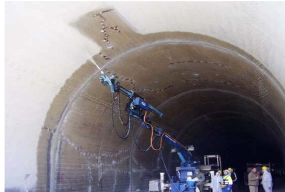
*Bild 8: Spritzauftrag der Membran mit vollautomatischem Roboter (Bild: BASF)*
