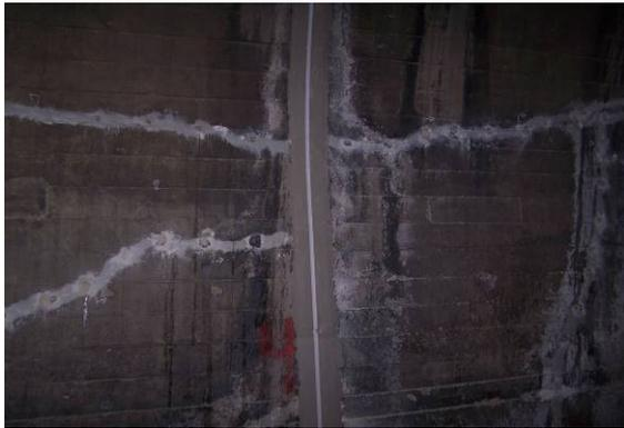
*Bild 7: Injizierte Risse und abgedeckte Bewegungsfuge (Bild: BASF)*
