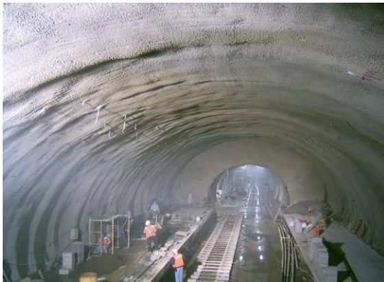
*Bild 1: Station Puente Alto, nach Ausbruch
