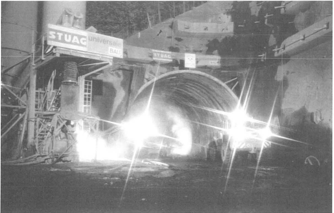
Bild 4: Vorratssilos und Spritzanlage vor dem Tunnelportal
