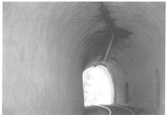
Bild 7: Zur Abdichtung ausgekleideter Tunnel Verguno, 1995
