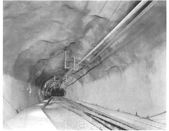
Bild 2: Tunnel Muralto - Sant'Antonio, Doppelspurstrecke; einschaliger Ausbau mit Spritzbeton, 1991
