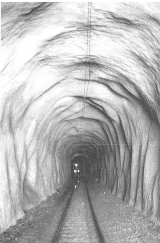
Bild 6: Einschaliger Ausbau mit Spritzbeton im Tunnel Dirinei, 1988 (ausgeführt 1969)
