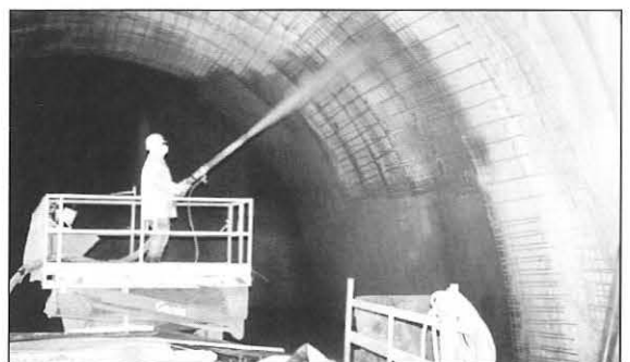
Bild 4: Aufbringen des Spritzbetons auf die PVC Dichtungsbahn
