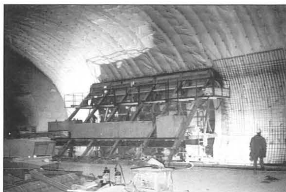
Bild 6: Kunststoff-Dichtungsbahnen und Betonierung eines Ulmenabschnittes
