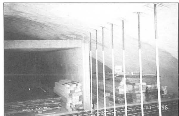
Bild 10: Bau der Luftkanäle
