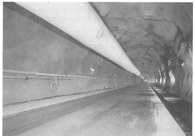
Bild 2: Spurstrecke Vereinatunnel Nord; einschalige Bauweise
