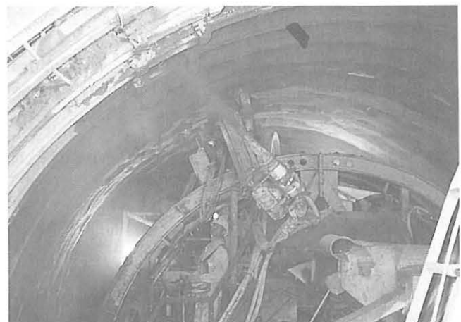
Bild 4: Spritzautomat, Baulos T4, Naßspritzbeton
