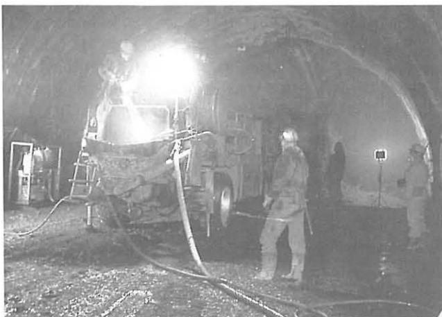
Bild 3: Cifa Spritzmobil, Baulos T2, Naßspritzbeton
