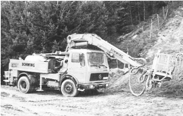
Abb. 5 Schwing-Gerät für das Naßspritzverfahren auf LKW-Fahrwerk.
