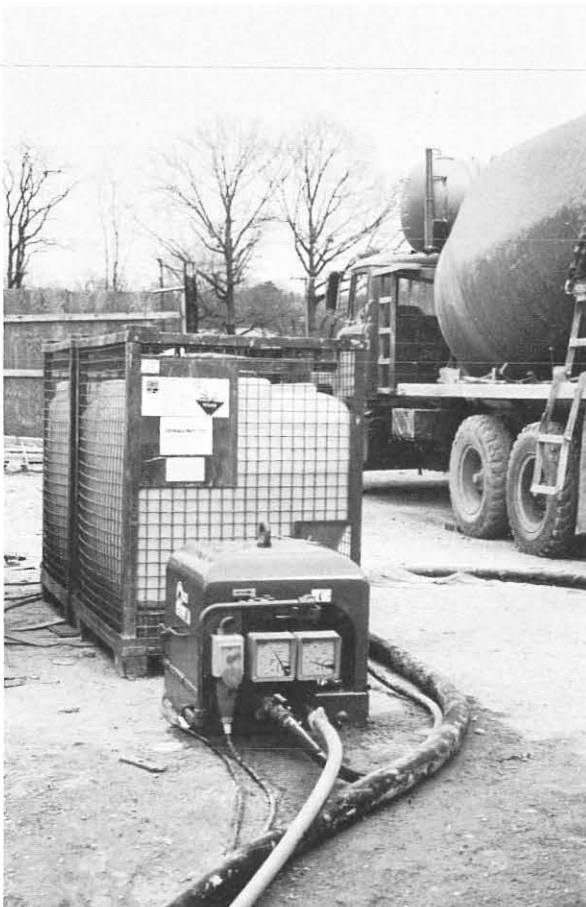
Abb. 1 DYNAGUNIT-BE und Panda Mix-Dosiergerät als Einheit für das Trockenspritzverfahren.
