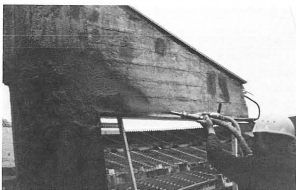
Abb. 2: Auftrag unter Baustellenbedingung
