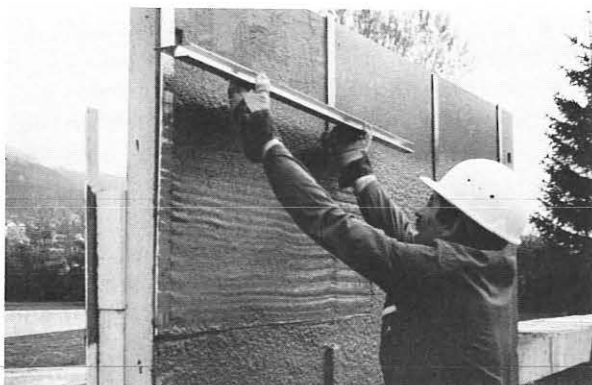
Abb. 3: Auftrag und Verarbeitung des Spritzgutes am Spritzstand
