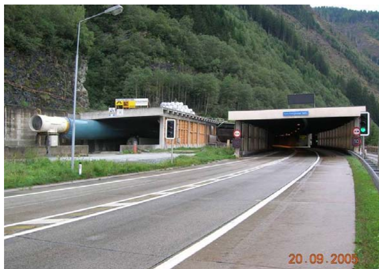
Bild 2: Katschbergtunnel 1. Röhre (rechts im Bild Richtungsfahrbahn Villach)
