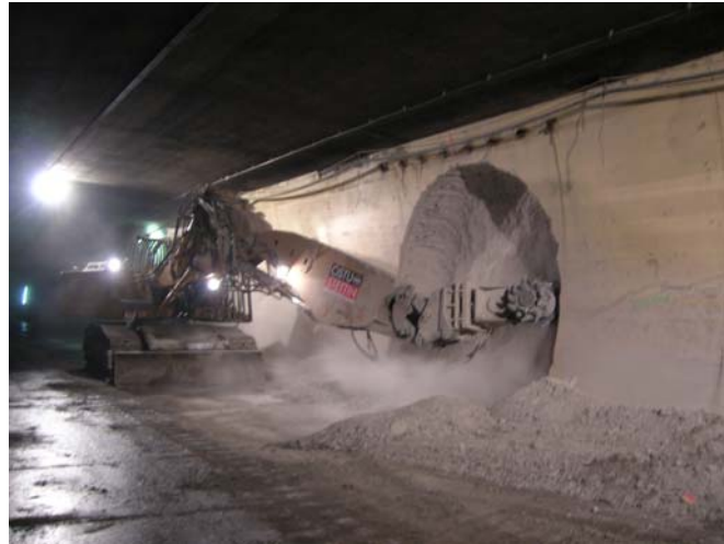
Bild 3: Katschbergtunnel 1. Röhre – Vortrieb der Querschläge vom Bestand aus
