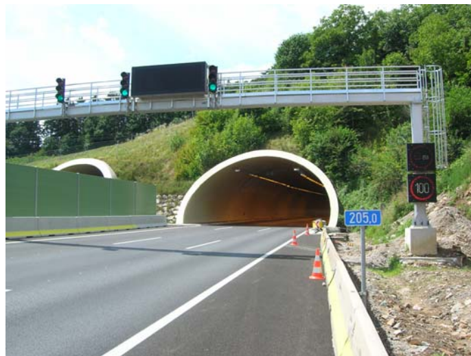
Bild 1: Tunnel Assingberg 1. Röhre (Richtungsfahrbahn Klagenfurt) nach Sanierung
