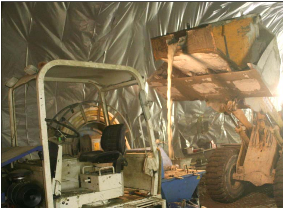
Bild 3: Per Radlader zum Spritzmobil transportiertes Bereitstellungsgemisch. Der Beton bietet sich trotz „unruhigem“ Transport mittels Radlader homogen dar. Keine Entmischungen infolge großer Fallhöhe. (Bild: MAPEI GmbH)
