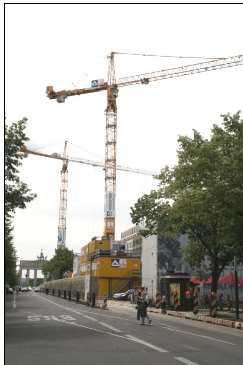
Bild 1: Baustelle eingepasst in örtliche Bebauung und Straßenführung. Im Falle prominenter Besucher aus Unterhaltung, Sport und Politik dieses zentralen Bereiches Berlins, werden Zufahrtsstraßen aus Sicherheitsgründen vorübergehend gesperrt. (Bild: MAPEI GmbH)
