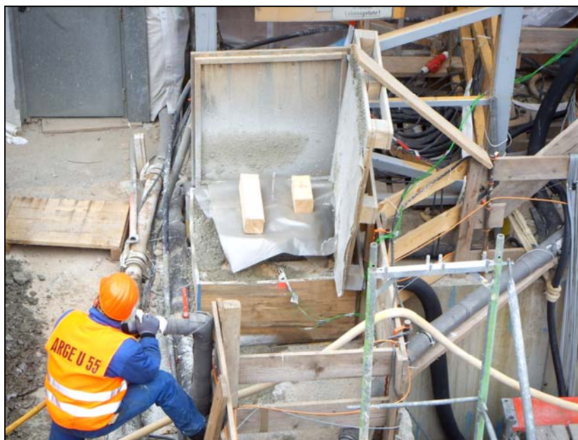
Bild 4: Überprüfung Frühfestigkeitsentwicklung auf der Baustelle (Bild: Rombold & Gfröhner GmbH)
