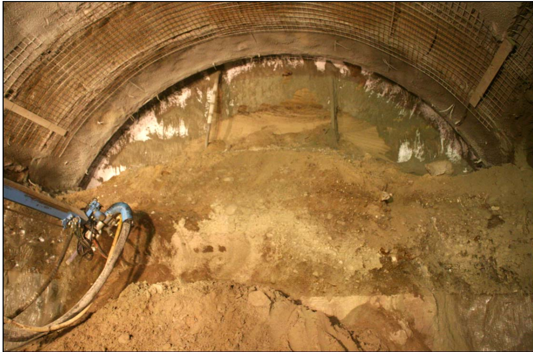
Bild 6: Spritzen auf vereistem Untergrund. Das Spritzbild im Bereich des direkt vor der Ortsbrust eingespritzten Bogens unterstreicht das gute Funktionieren des Spritzbetons auf dem vereisten Untergrund. (Bild: MAPEI GmbH)
