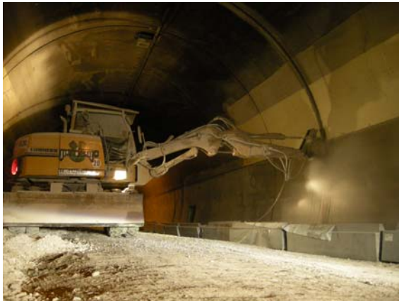
Bild 10+11: Ulmenschlitz Fräsen/Verschließen Südröhre BA1, 01/08 (Bild: ARGE)
