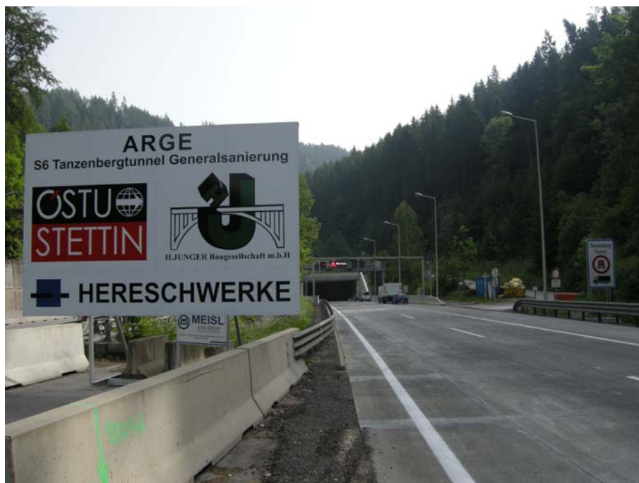
Bild 1: Baustelle Tanzenbergtunnel, 05/08 (Bild: ARGE)
