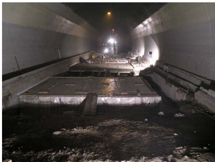
Bild 2: Sanierung Störzone-Südröhre BA1, 11/07 (Bild: ARGE)
