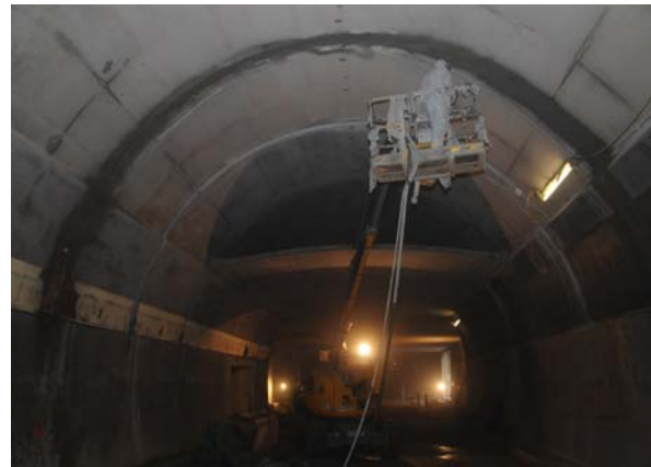
Bild 10+11: Ulmenschlitz Fräsen/Verschließen Südröhre BA1, 01/08 (Bild: ARGE)
