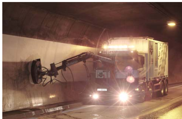
Bild 4+5: HDW-Betonabtrag Südröhre BA1, 11/07 (Bild: ARGE)
