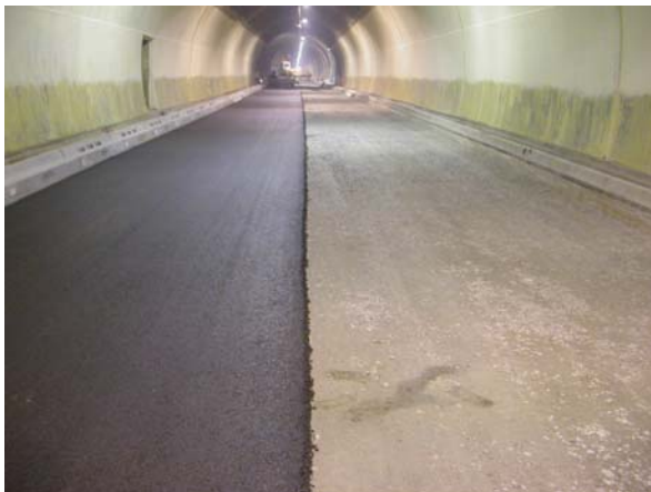
Bild 12+13: Unterbau/Einbau Betondecke Südröhre BA1, 04/08 (Bild: ARGE)
