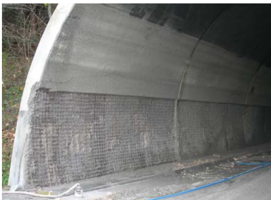
Bild 4+5: HDW-Betonabtrag Südröhre BA1, 11/07 (Bild: ARGE)
